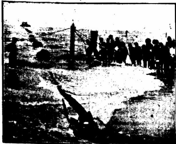
NA ROCKWAY-STRAND KOŁO NOWEGO JORKU kładzie się nowo założony kabel telegraficzny, który na przestrzeni 6000 kilometrów łączy Anglię ze Stanami Zjednoczonymi. Jest on tak silny, że może wytrzymać 2500 ton na minutę. Prace na ośmiu rąk przedni nie wstrzymują.
